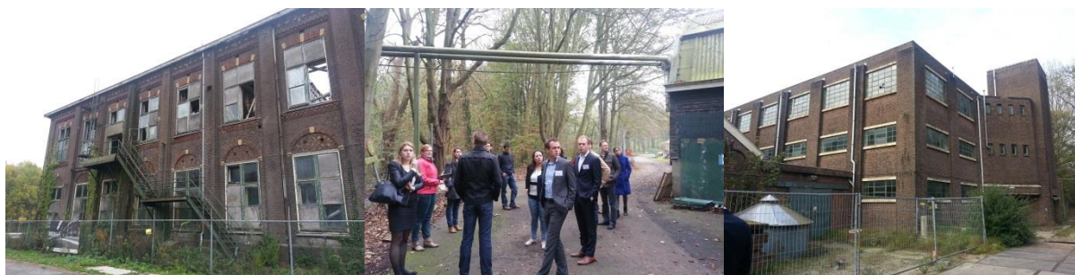
Links: Het voormalige wapendepot: rijp voor renovatie. Rechts: gebouw 'De Dood'
